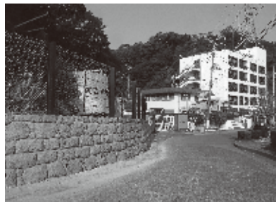
【市道鷓島大浦線落石防止工事】
