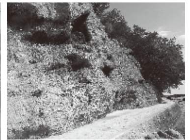
【市道鷓島大浦線法面修繕工事】
